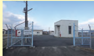
4 宮前第2水源地
