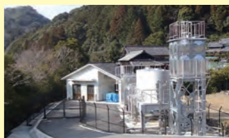
14 床ノ木水源地
