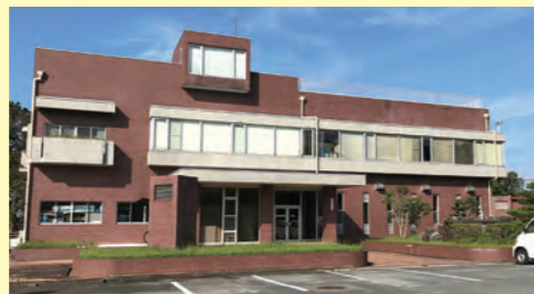
水道管理センター (中須水源地)
