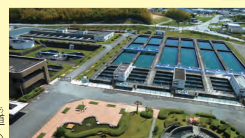
三重県南勢水道 多気浄水場
