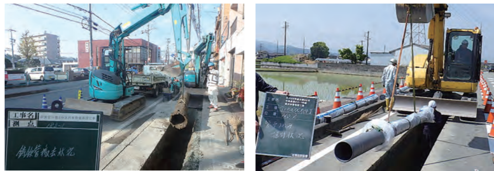
古い水道管を地震に強い水道管に取り替えているところ
