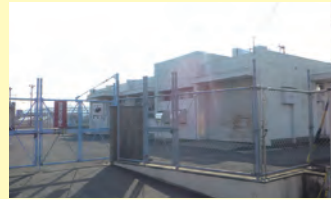
3 宮前第1水源地
